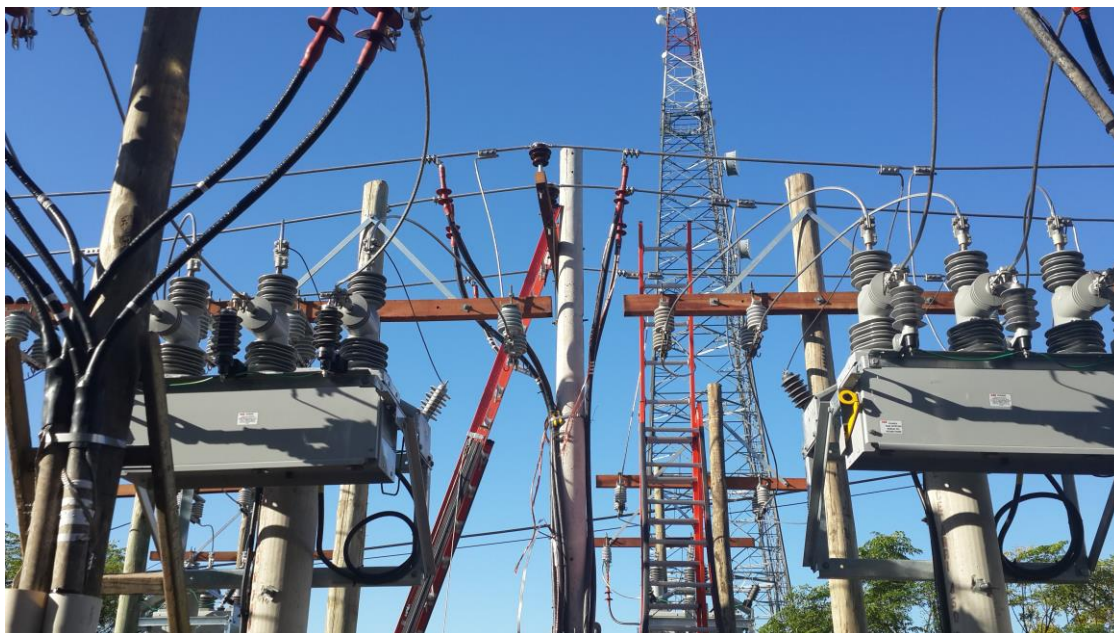
Fig 5 – Construcción de playa intemperie de 13,2kV
